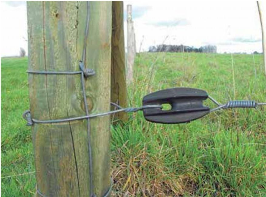
**Figura 8.6.** Estacas y aisladores terminales.
